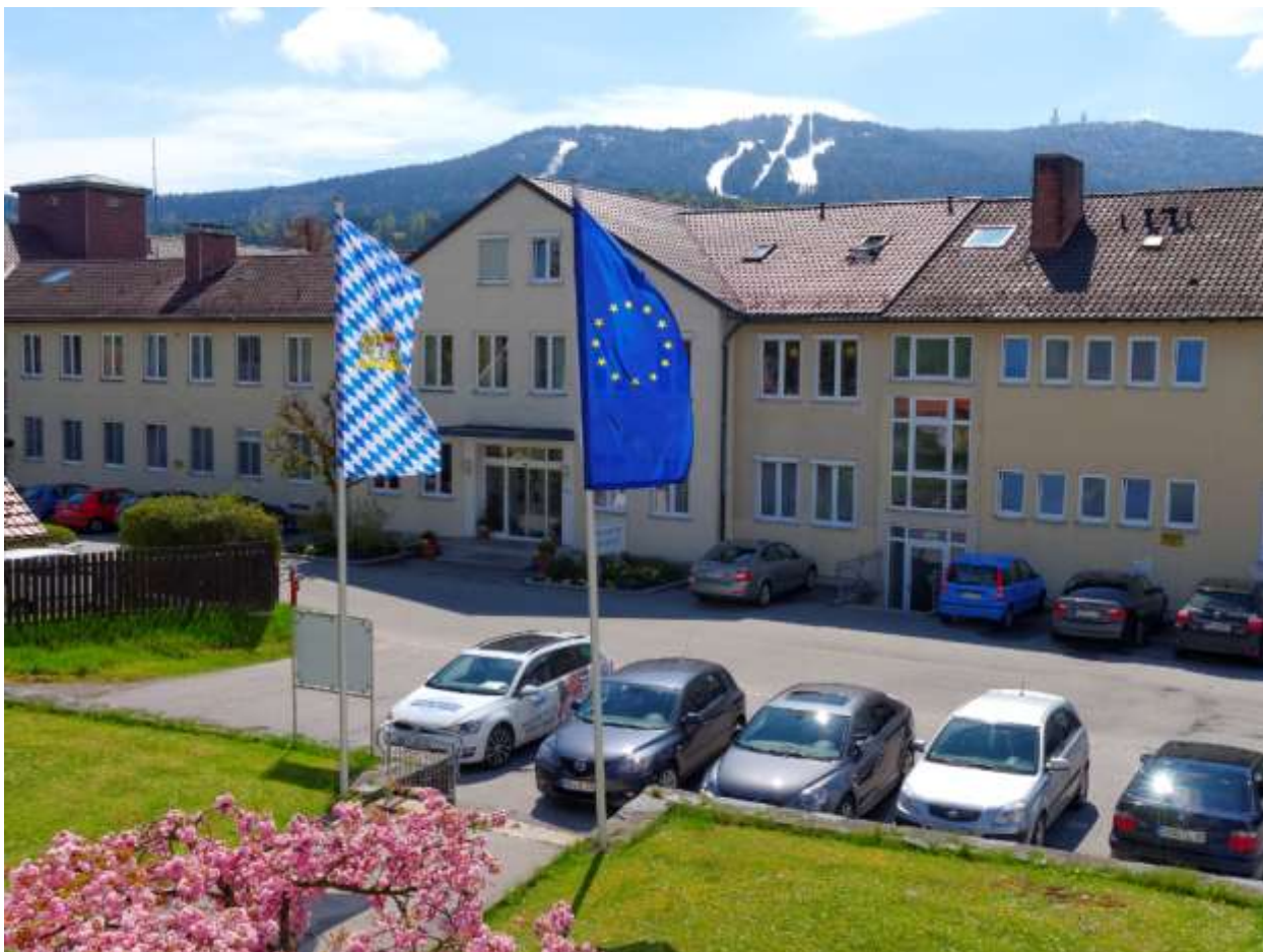
Hauptgebäude der Spezialklinik Neukirchen in Neukirchen b. Hl. Blut
